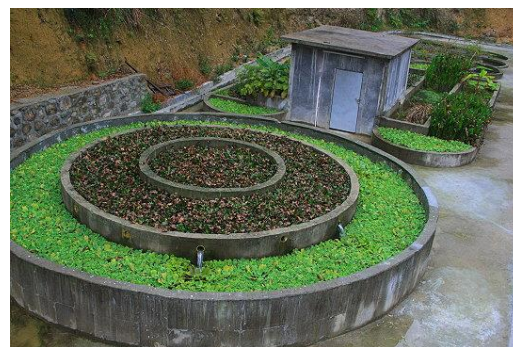
廠區內污水處理設施
