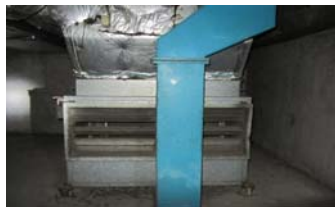
機房不堆雜物
